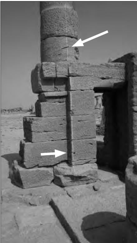
Überall erkennt man noch die mit weißer Farbe aufgetragenen Linien (Pfeile), die man verwendete, um die Einzelteile wieder korrekt zusammen zu bauen.
